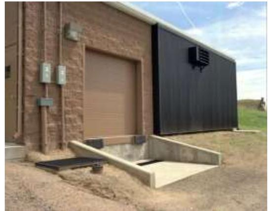
Fig. 3.4. Solar air heaters
